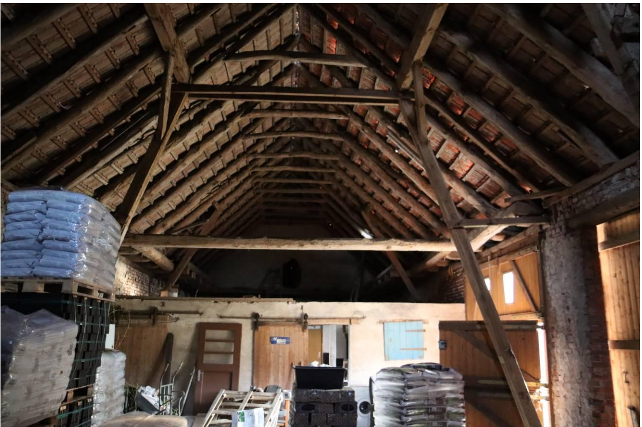
Abbildung 10: Dachstuhl des Nutztraktes (Scheune/Stall) – Blick nach Westen.
