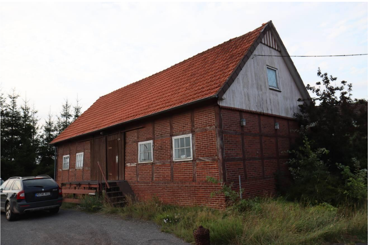
Abbildung 18: Südwestansicht des Lager- und Vereinsgebäudes (Gebäude 3) im Nordwesten des Hofgeländes.
