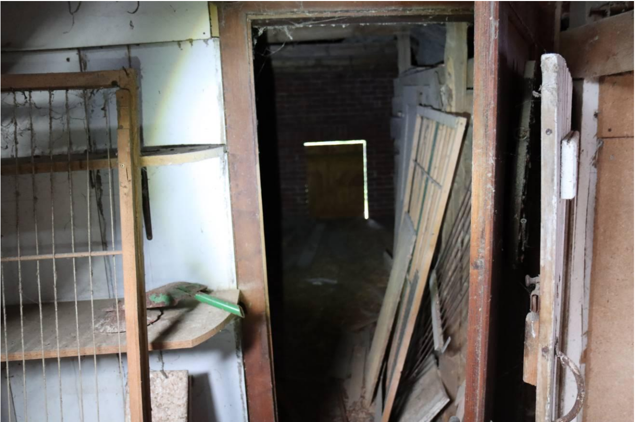
Abbildung 15: Dachräume im Stall- und Lagergebäude – Blick nach Süden.
