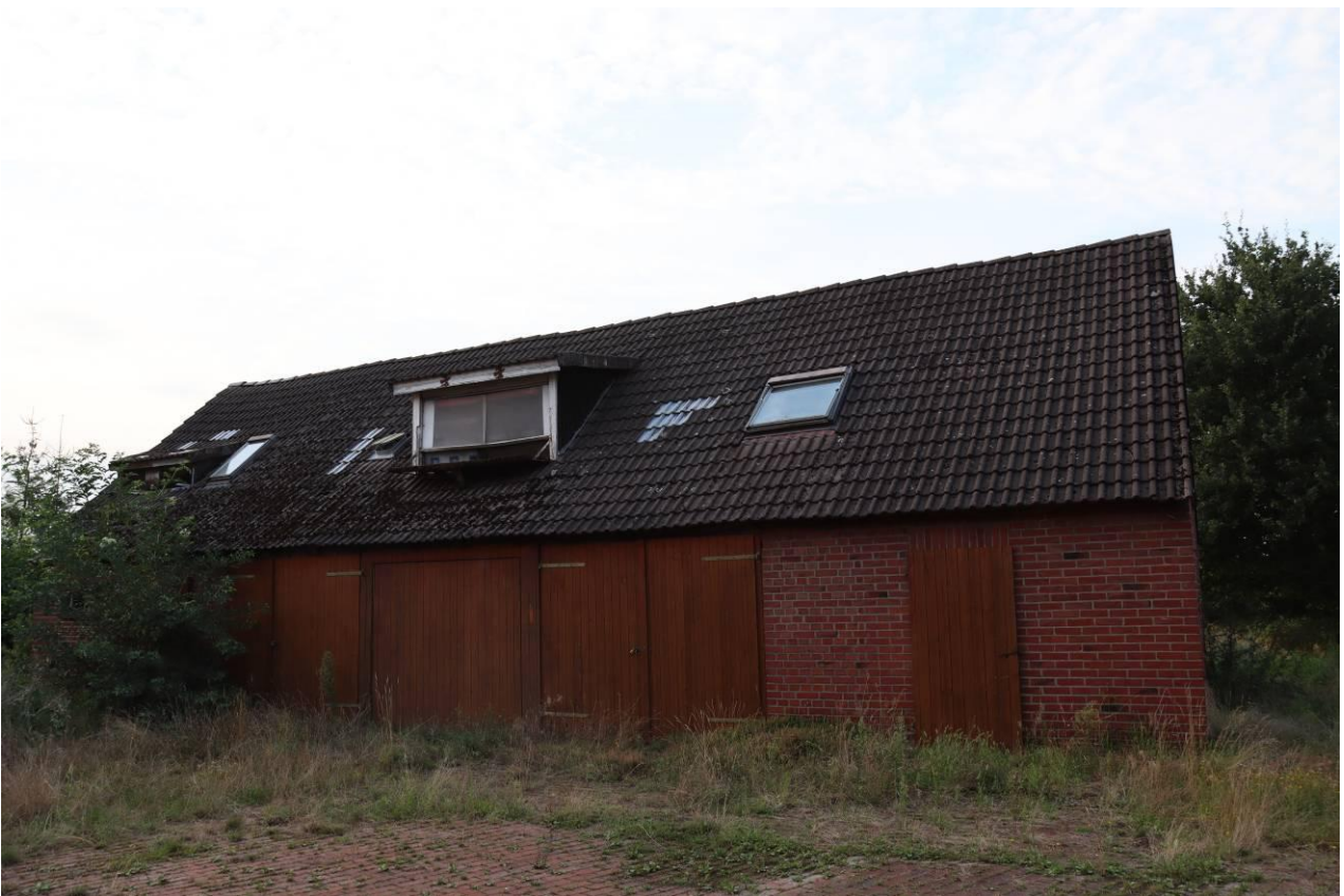
Abbildung 15: Westansicht des Stall- und Lagergebäudes mit Taubenschlag (Gebäude 2) im östlichen Teil der Hofstelle.
