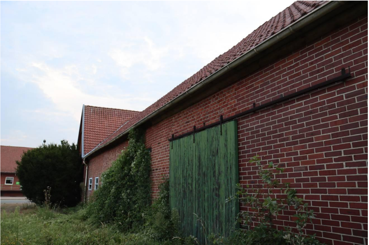
Abbildung 5: Südseite des Hauptgebäudes – Blick nach Westen. Angrenzend an das Gebäude bestehen Anpflanzungen verschiedener Kleingehölze.
