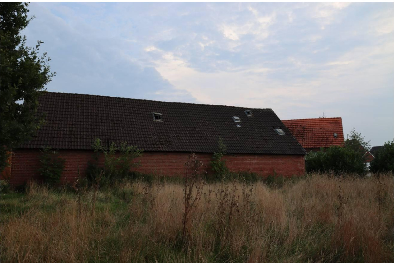
Abbildung 16: Ostseite des Stall- und Lagergebäudes.
