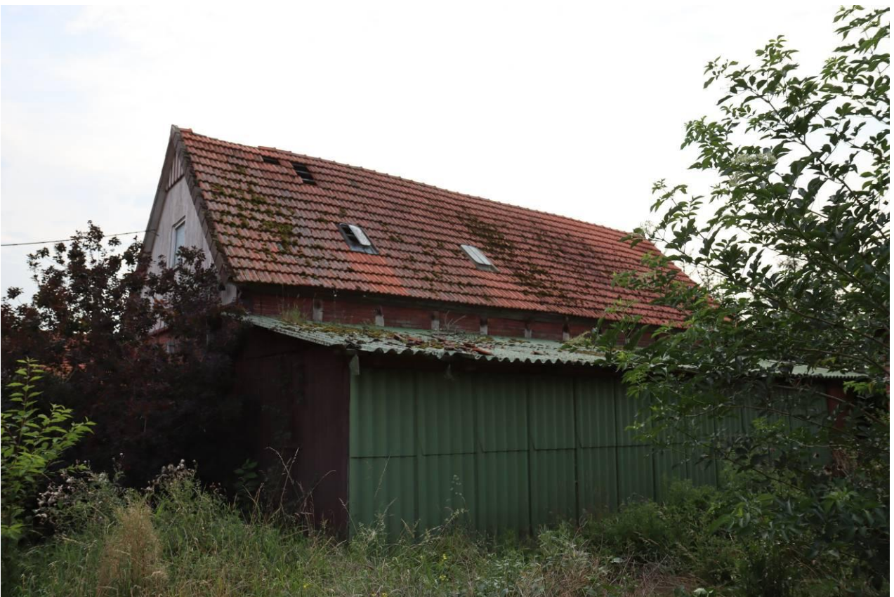
Abbildung 21: Ostansicht des Lager- und Vereinsgebäudes.
