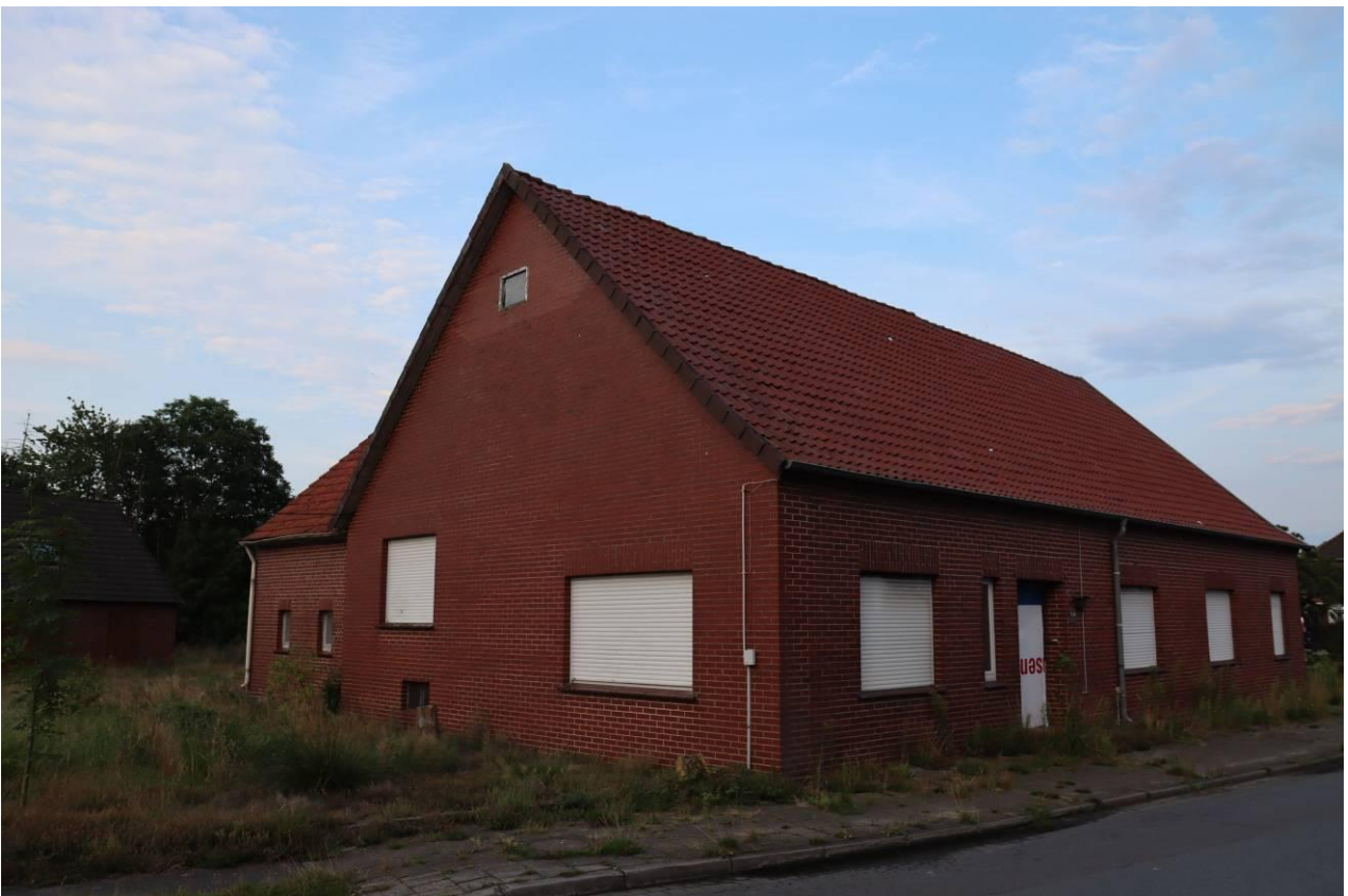
Abbildung 2: Nordwestansicht des ehemaligen Wohngebäudes.
