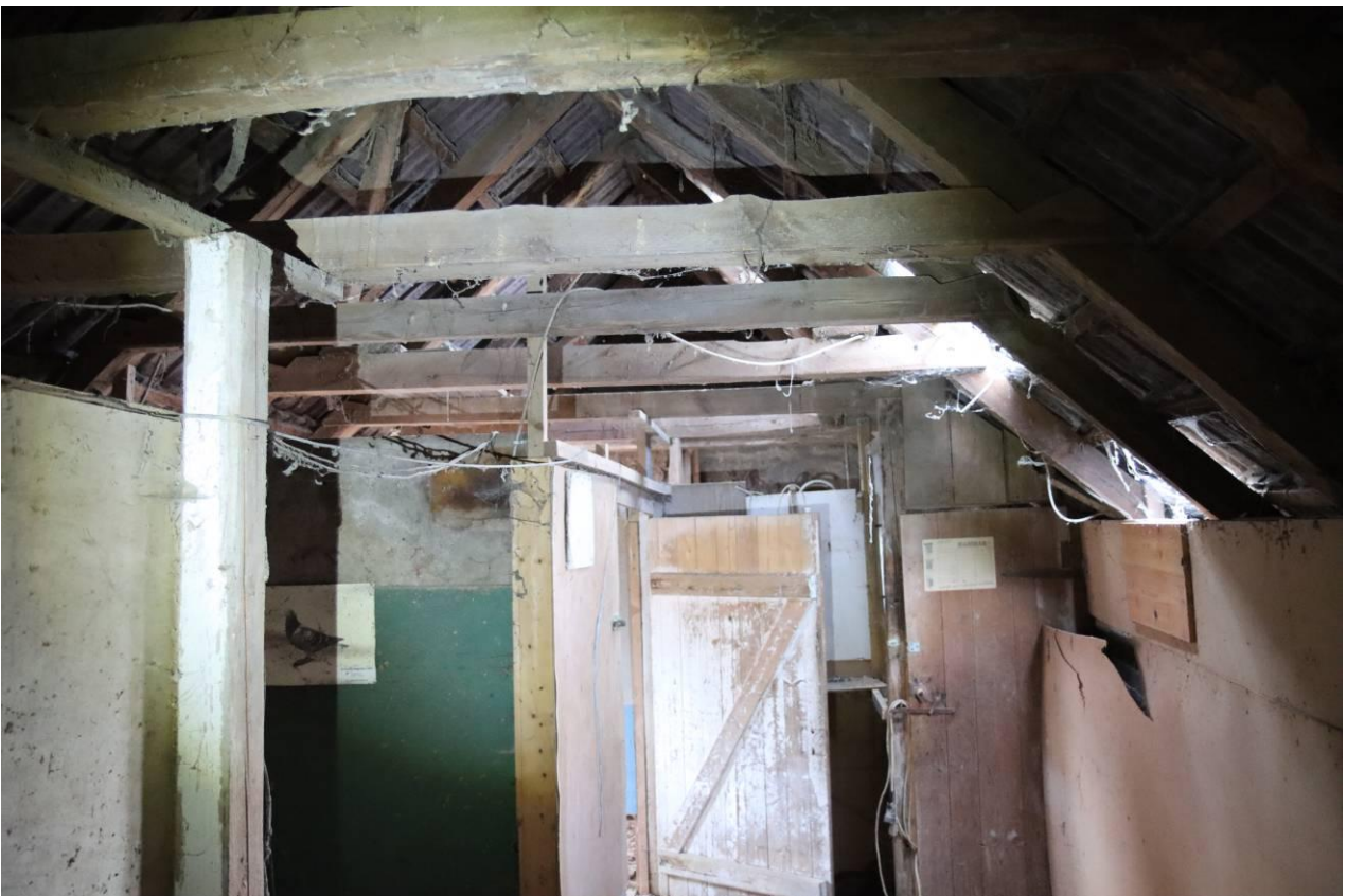
Abbildung 16: Dachräume im Stall- und Lagergebäude – Blick nach Norden.
