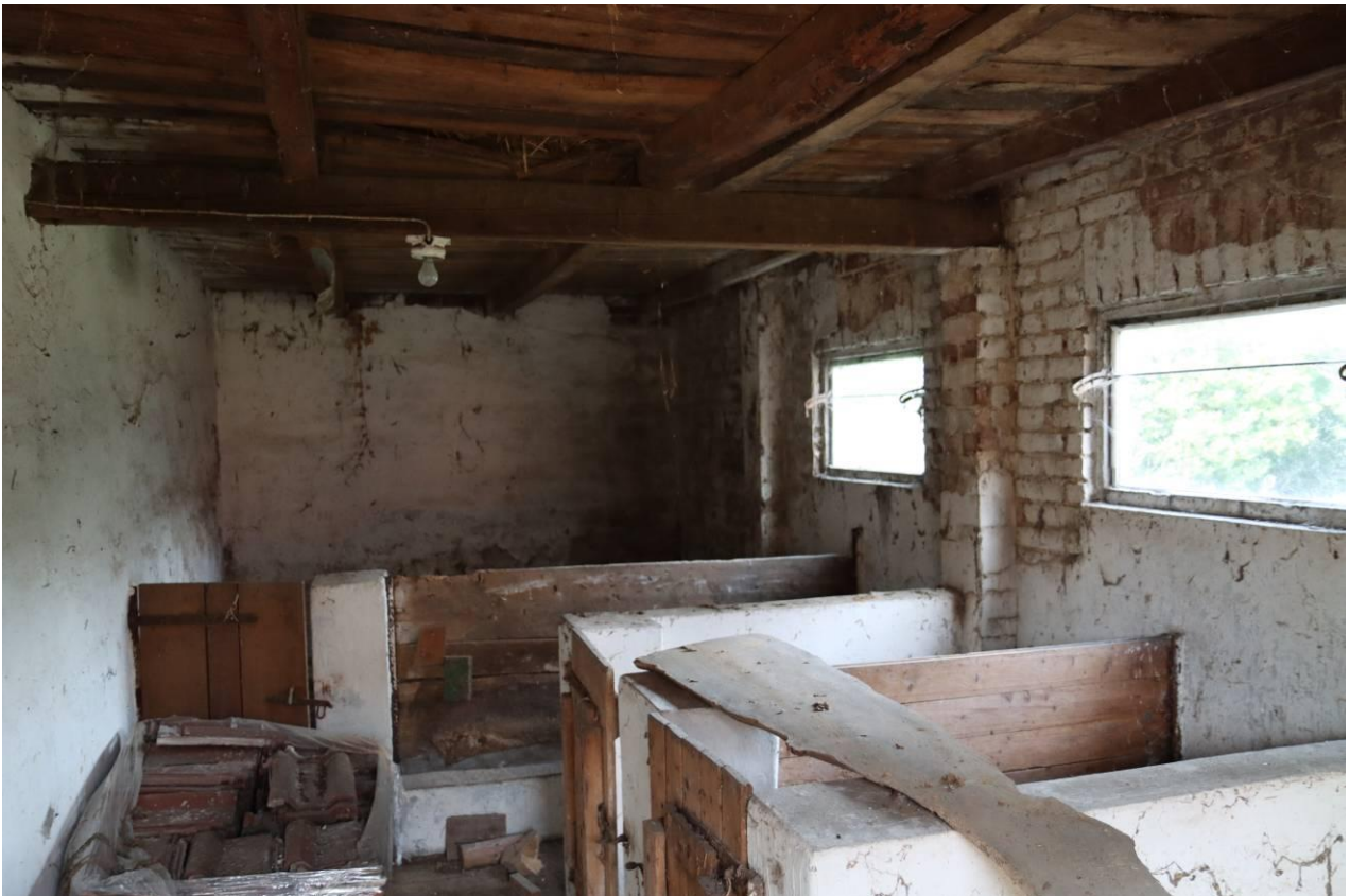
Abbildung 13: Ehemalige Stallungen im südlichen Teil des Stall- und Lagergebäudes.
