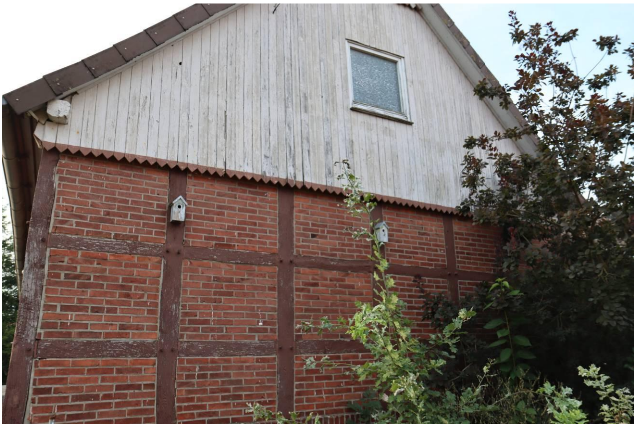
Abbildung 19: Nistkästen für Kleinvögel auf der südlichen Giebelwand des Gebäudes.
