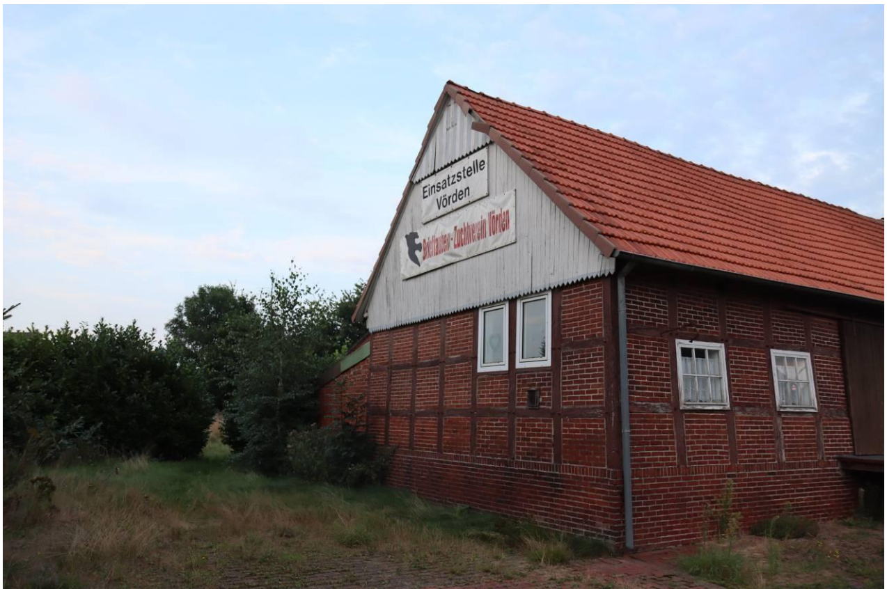
Abbildung 20: Nordwestansicht des Lager- und Vereinsgebäudes.
